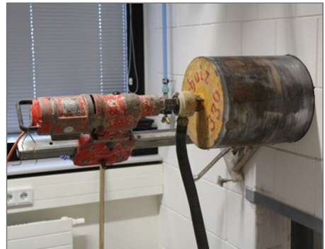
Abb.2 - Kernlochbohrung
