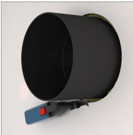
Abb.3 - PVC-Kernrohr einkürzen
