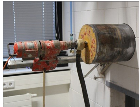
Fig. 2 - Perçage de l'avant-trou
