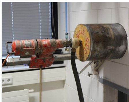
Rys. 2 - Otwór w ścianie
